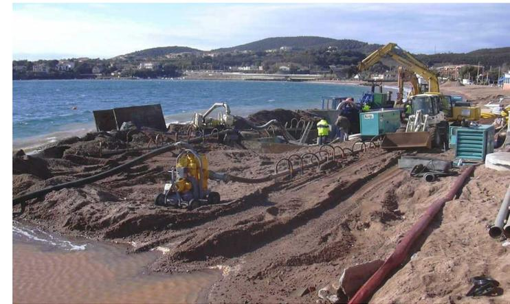
Mise en œuvre du système de drainage Ecoplage sur la plage d'Agay (St-Raphaël) en 2004
