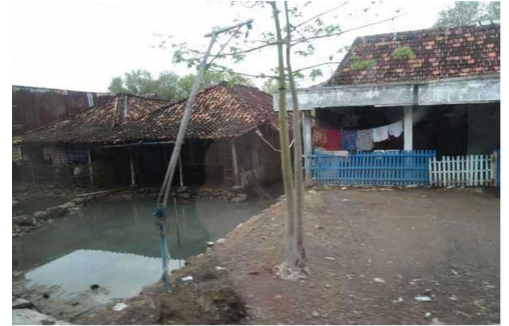
Subsidence du bâti (à gauche) et surélévation d'un terrain (à droite)
