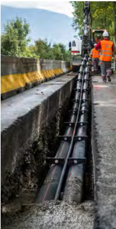
A la fin des travaux d'enfouissement des câbles, le sol est remis en état
