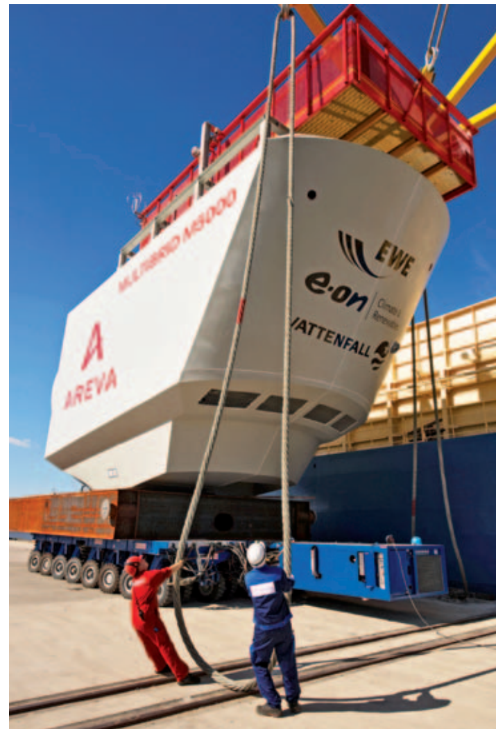
/// Mise en place des éoliennes du parc éolien en mer alpha ventus
