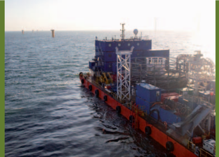
/// Installation des câbles dans le parc de Lincs offshore wind farm
