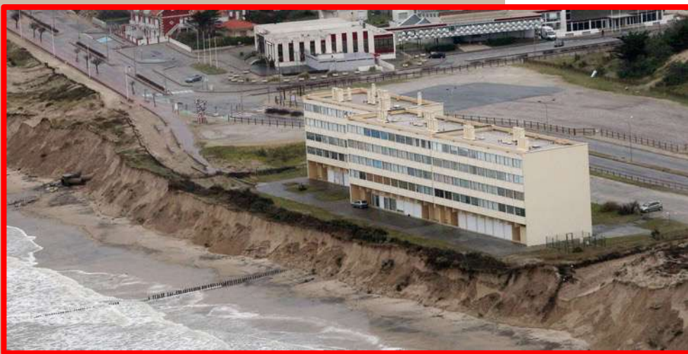
Le Signal, à Soulac sur Mer, a été démoli en février 2023.
