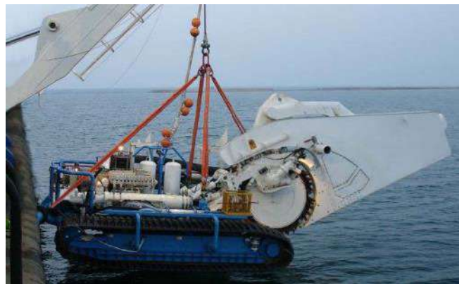
Trancheuse mécanique à roue (Crédit photo Rte)
