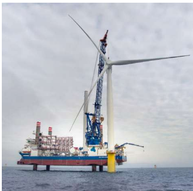
Installation d'une éolienne en mer par un navire jack-up pour le parc éolien de Dudgeon (Source : Siemens Gamesa Renewable Energy)
