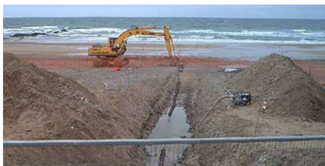
Forage dirigé ou Tranchée sur l'estran (Crédit photos Rte)
