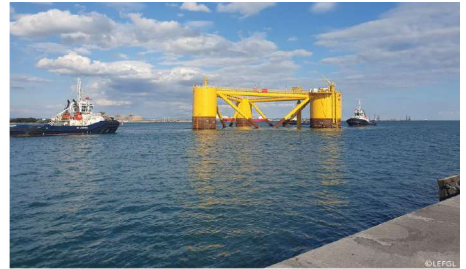
Entrée du premier flotteur de Principle Power pour la ferme pilote éolien flottant golfe du lion ©Europort Mai 2025
