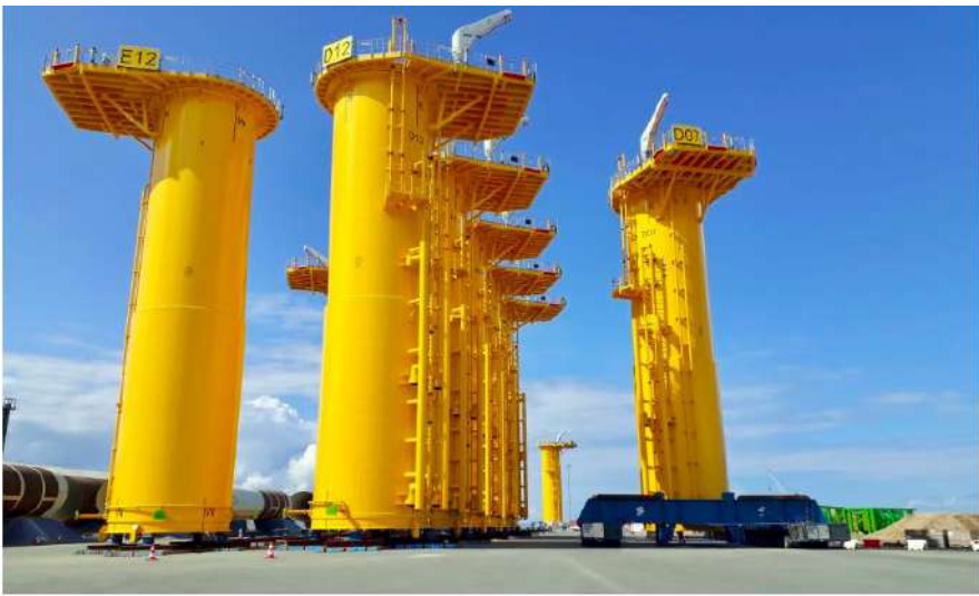
Fondations éoliennes posée du parc éolien en mer de Fécamp ©EDF renouvelables
