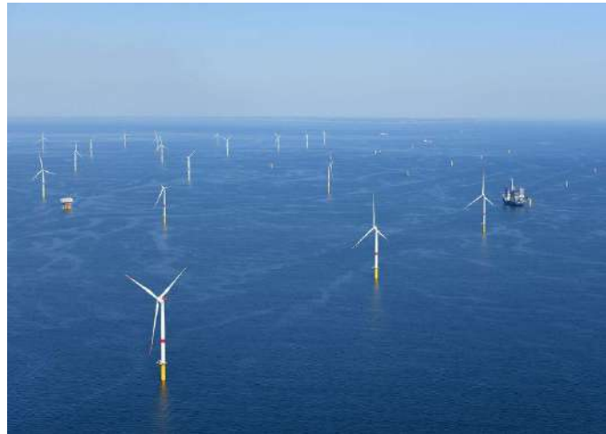
Banc de Guérande EDF Renouvelables 80 Haliade 480MW
