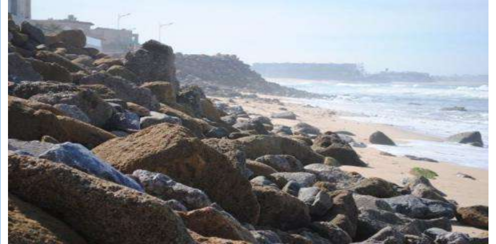
Enrochements Mohammedia ©Duncan Driffort, 2021
