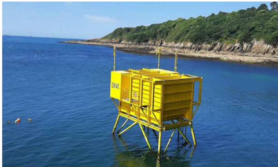
Digue portuaire Dikwe ©Groupe Legendre Ifremer Geps Techno
