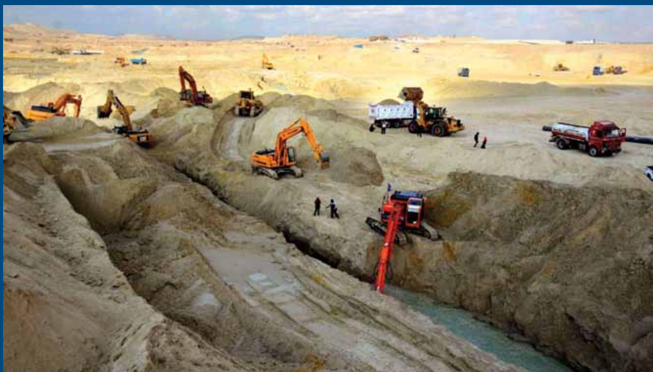
Derniers travaux de réaménagement du Canal, lors de son extension.
