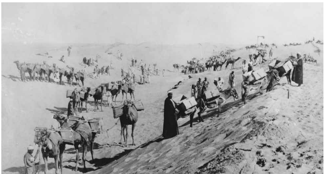
Plusieurs centaines de milliers d'ouvriers travaillèrent au creusement du Canal, simplement équipé de pelles et de pioches, avant que des machines soient apportées sur le chantier © D.R.
