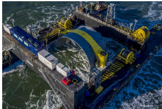
Mise à l'eau de l'hydrolienne d'OpenHydro dans la baie de Fundy (Canada), en 2016
